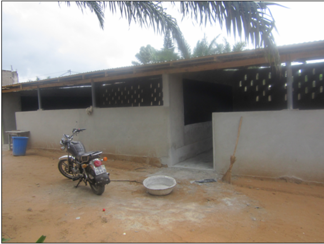
de uitbreiding van de nieuwe lokalen
