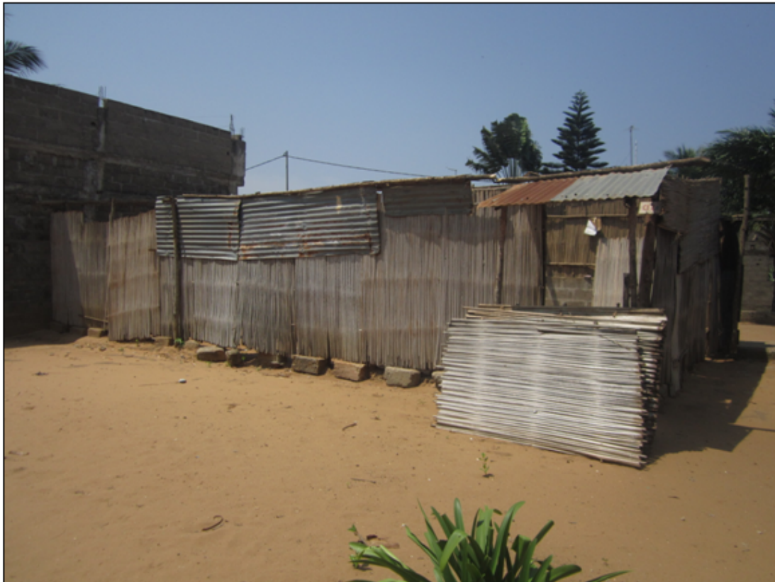
de bestaande 2 lokalen
