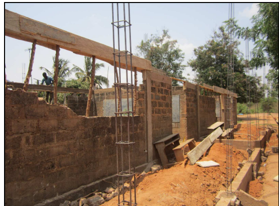
de verbouwing begint
