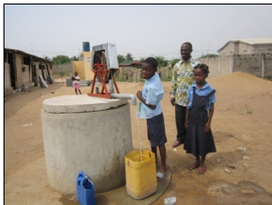
nieuwe waterput met touwpomp
