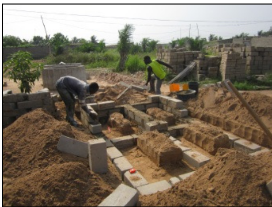
plaatsing van fundering latrine
