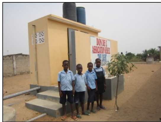
nieuw toiletgebouw met grote wasbak
