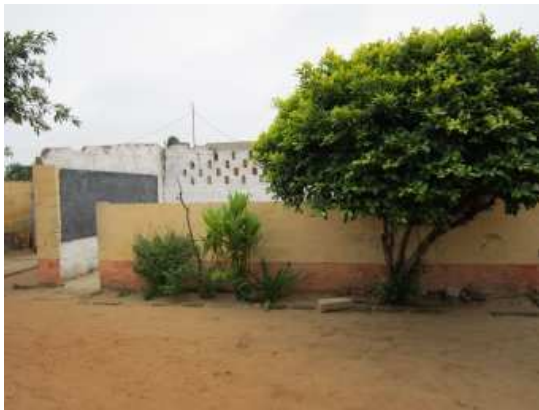
lokalen zonder dak
